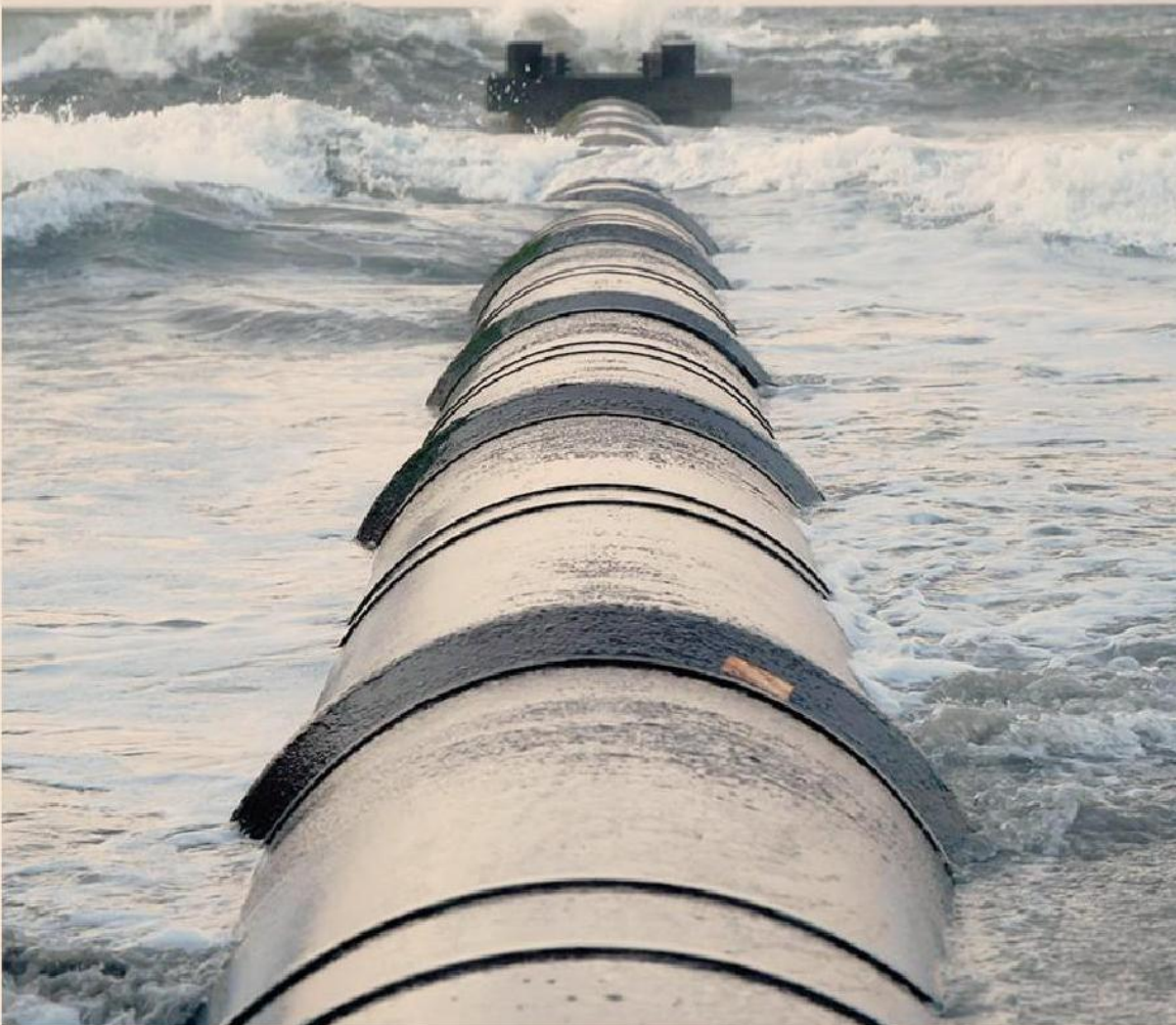
La posa. Il progetto Unitirreno è partito da oltre un anno e il mese prossimo inizia la posa a Mazara del Vallo
